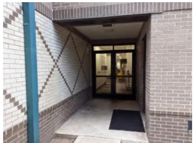
12. Side exit door
