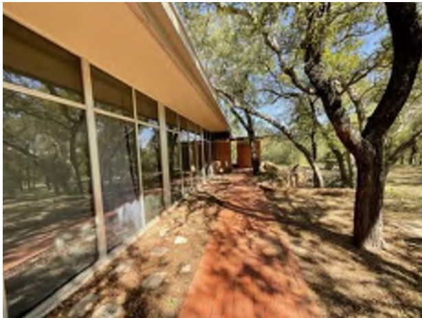
21. Annex: East Façade
