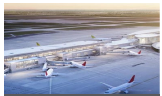
Expansión del terminal del aeropuerto
