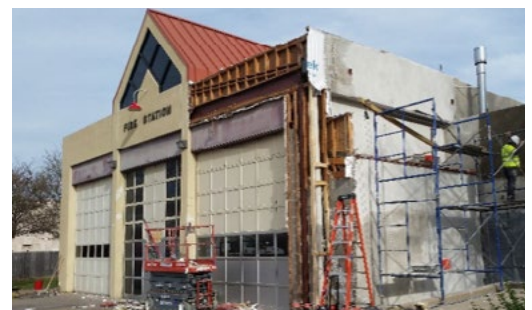
城市設施維護
