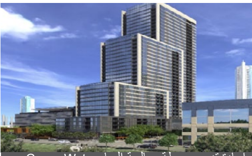
إعادة تدوير محطة معالجة المياه Treatment Plant Redevelopment
