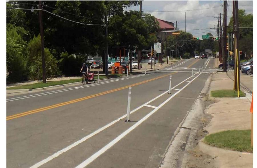
Ejemplo de una ciclovía protegida unidireccional en Manor Road construidas con palos flexibles.
