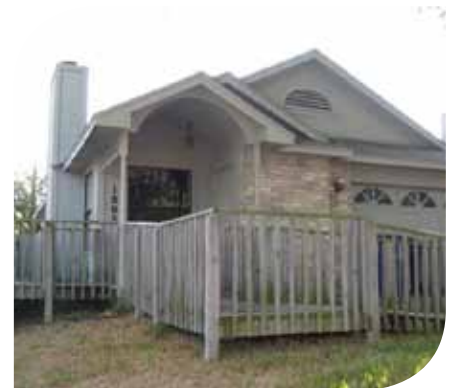
Reparación de casas-modificaciones para accesibilidad
