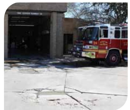
Reemplazar entradas de camiones en estaciones de bomberos
