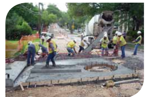
Reconstrucción de calles
