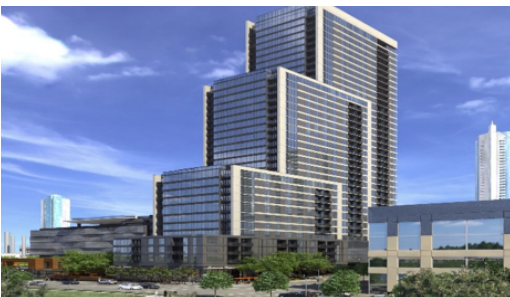
إعادة تدوير محطة معالجة المياه Treatment Plant Redevelopment
